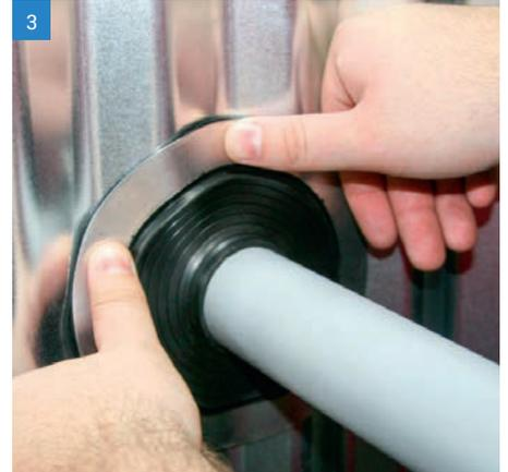
3 Drücken Sie den Master Flash® Low Profile nach unten und biegen Sie es so, dass es sich dem Dachprofil oder Unregelmäßigkeiten anpasst. Ein stumpfes Werkzeug hilft bei der Formung von Eindeckrahmen in engen Dachwinkeln.
