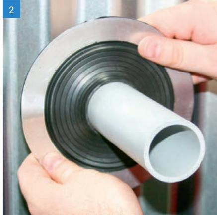
2 Schieben Sie den Master Flash® Low Profile in das Rohr und verwenden Sie ein nicht-ölbasiertes Schmiermittel, um den Einbau zu erleichtern.
