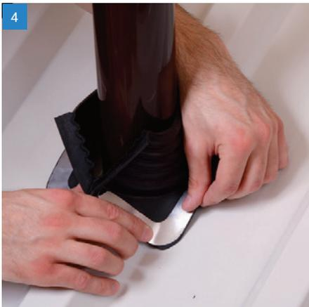
4 Passen Sie den Master Flash® Multi durch Druck an das Profil oder an Unebenheiten an. Ein stumpfes Werkzeug hilft dabei, die Manschette in enge Dachwinkel zu drücken.
