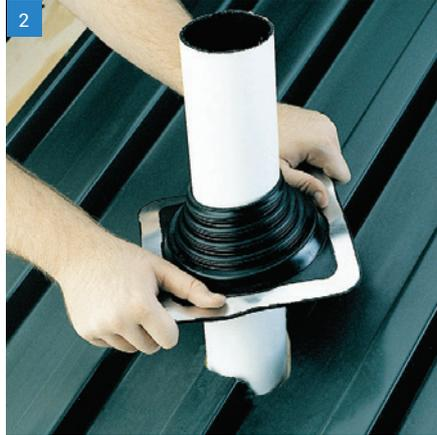
2 Ziehen Sie den Master Flash® über das Rohr bis nach unten. Ein Erdöl freies Schmiermittel kann die Installation erleichtern.
