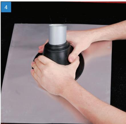
4 Ziehen Sie den Master Flash® über das Rohr bis nach unten. Ein Erdöl freies Schmiermittel kann die Installation erleichtern.
