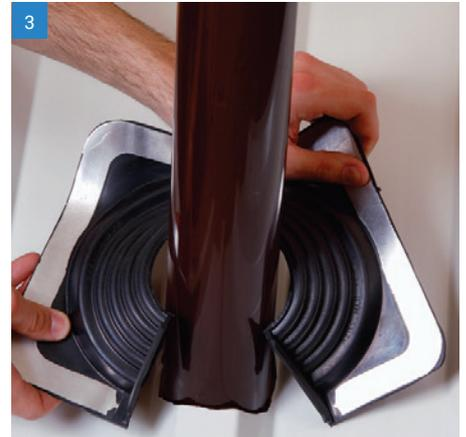
3 Ziehen Sie den Master Flash® Multi über das Rohr bis nach unten. Ein Erdöl freies Schmiermittel kann die Installation erleichtern. Bei Verwendung als Retrofit legen Sie das Produkt um das Rohr herum.
