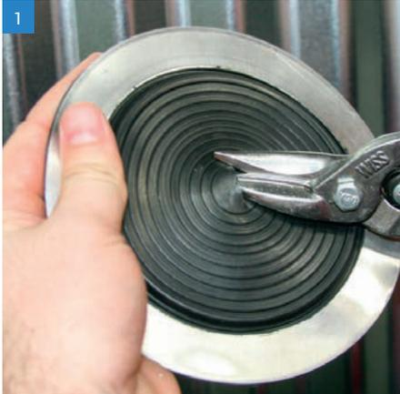
1 Wählen Sie einen geeigneten Master Flash® Low Profile mit einem Rohrbereich, der unter und über die passende Größe hinausgeht. Falls erforderlich, verwenden Sie die auf dem Eindeckrahmen deutlich gezeigten Linien, um eine Öffnung zu schneiden, die 20-30% kleiner als der Rohrdurchmesser ist.
