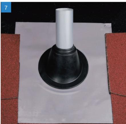
7 Befestigen Sie zunächst die Dachpappen an den beiden Seiten des Master Flashes®.
