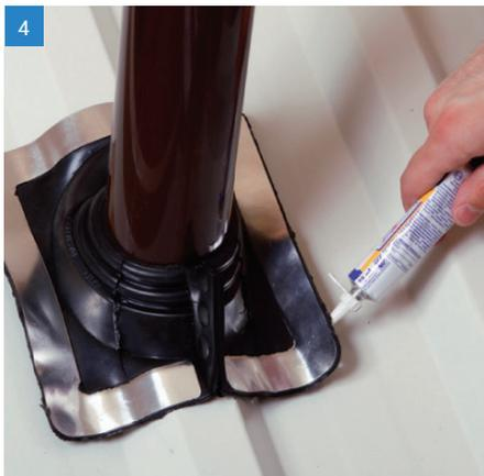
4 Tragen Sie das Dichtmittel zwischen Master Flash® und dem Dach, sowie an der oberen Öffnung der Manschette, auf.
