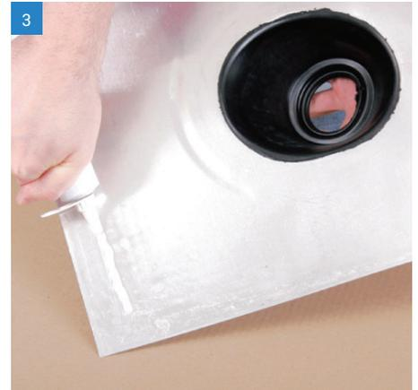
3 Tragen Sie das Dichtmittel auf der Unterseite der Metallplatte auf.
