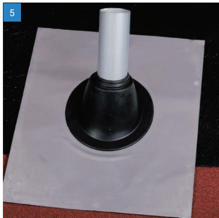
5 Schneiden Sie die Dachpappen so, dass sie an die Oberseite der Manschette passen. An der Unterseite wird die Metallplatte auf die Dachpappen gesetzt und befestigt.
